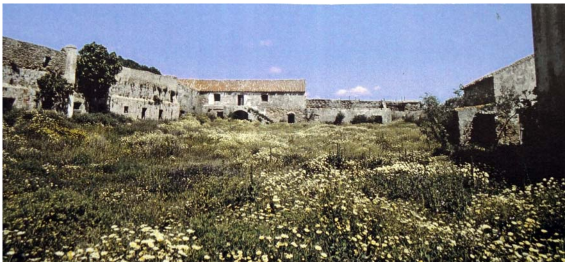
Patio de almacenes de la Chanca
